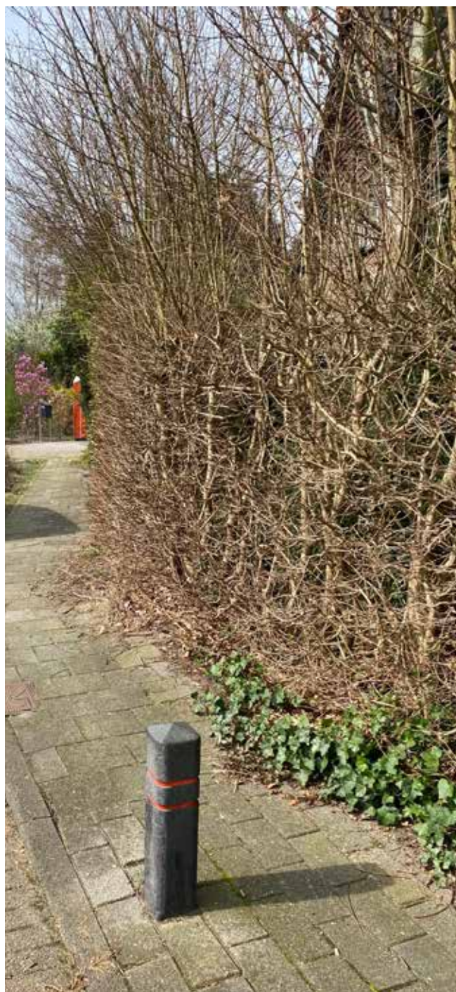
SLECHTS 50% VAN HET TROTTOIR IS HIER BRUIKBAAR!
